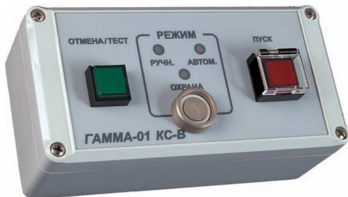
Рис. 8. КС-В. Общий вид
